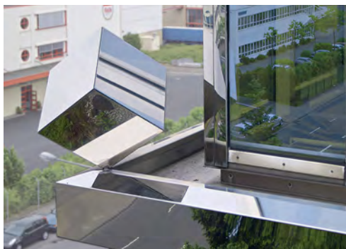
Blankglöddad fasadpanel före och efter rengöring: Med vanlig underhållsrengöring återfår den starkt reflekterande ytan sin ursprungliga lyster. Foto: Christian Pohl GmbH, Köln (D)
