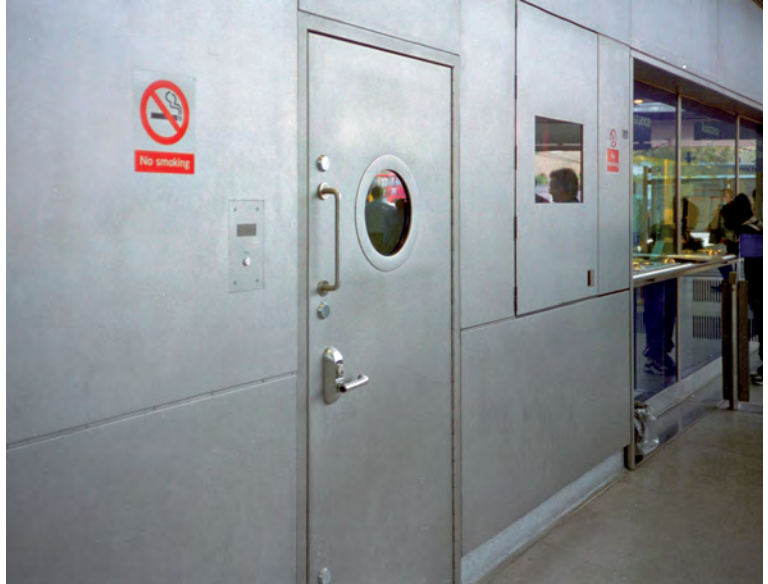
Glasblästrat rostfritt stål har visat sig ha bra motstånd mot mekanisk åverkan i ett utsatt läge vid Southwark järnvägsstation (UK).
